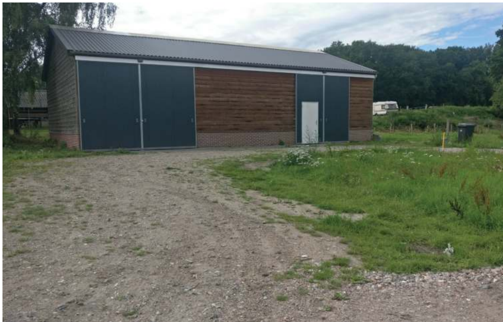
Schuur met puinverharding vanuit het westen gezien.
