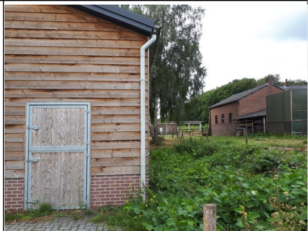
Afbeelding: bestaande schuur (zomer 2020), kijkrichting naar het zuiden, pad en rechts woonbebouwing bij Hartenseweg 9.
