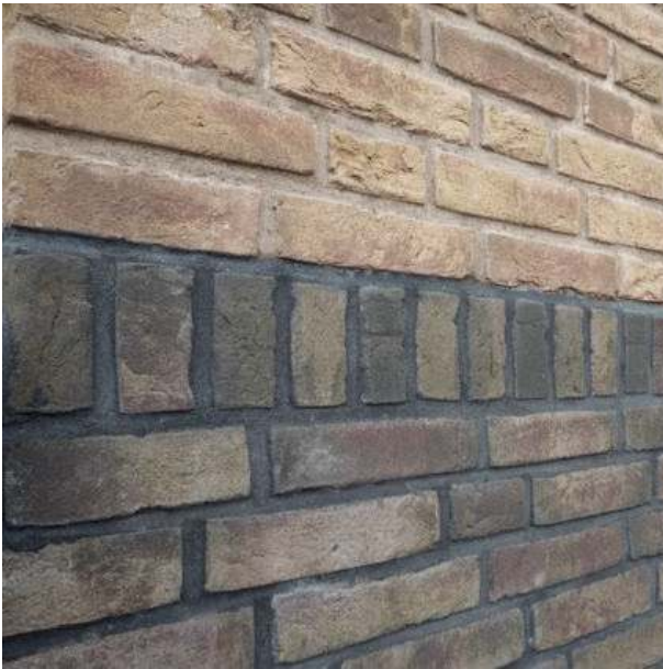
Vlakverdeling in het metselwerk door variatie in verband en kleur
