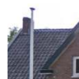
Zadeldak met nok (puntgevel) Zwarte dakpan
