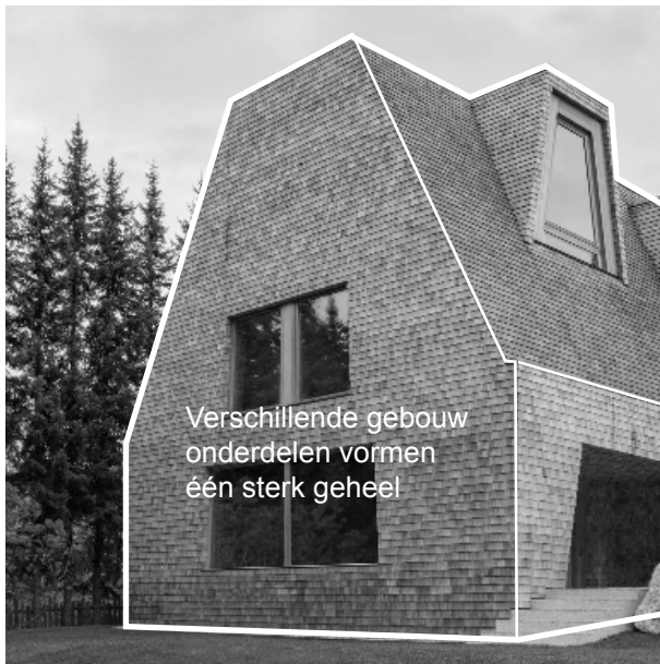
Contrast in tektoniek kerk (compositie van gebouw delen) en nieuwbouw (monolithisch geheel)
