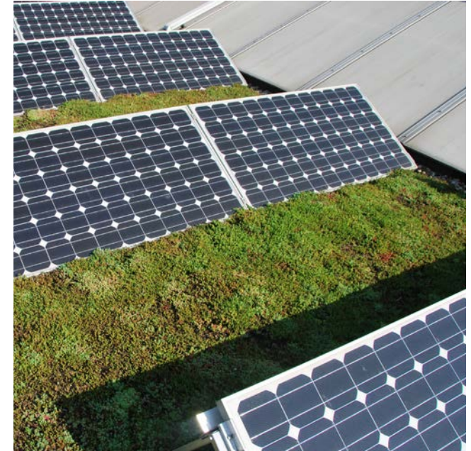
Groene daken en zonnepanelen
