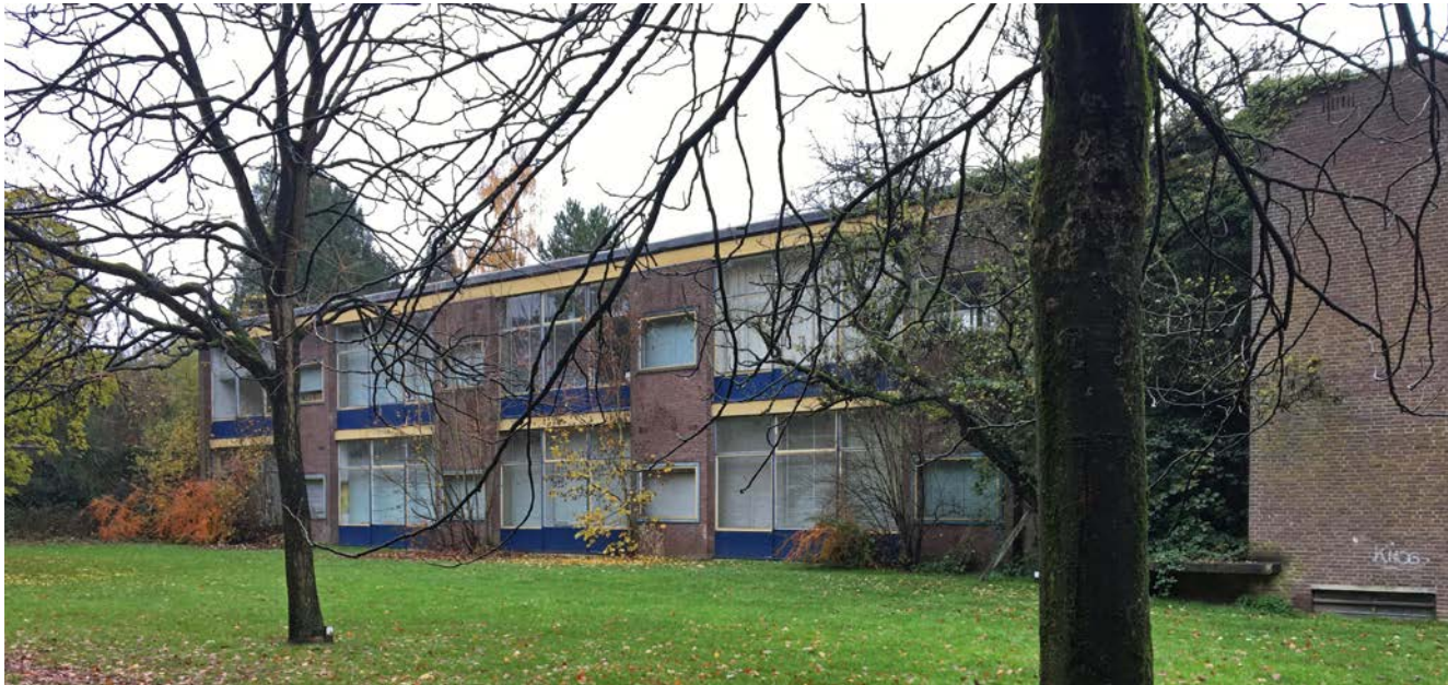
In de voormalige Pieter Reijnga Mavo zijn nu ateliers gevestigd
