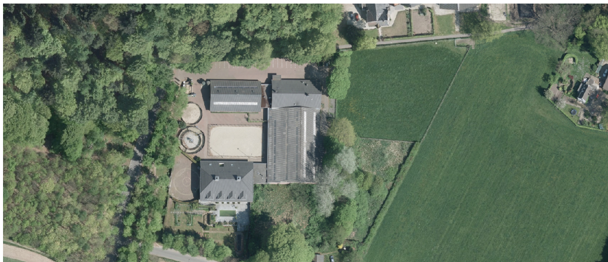
Afbeelding 2.1: luchtfoto situatie in 2016 (bron: GoogleMaps)
