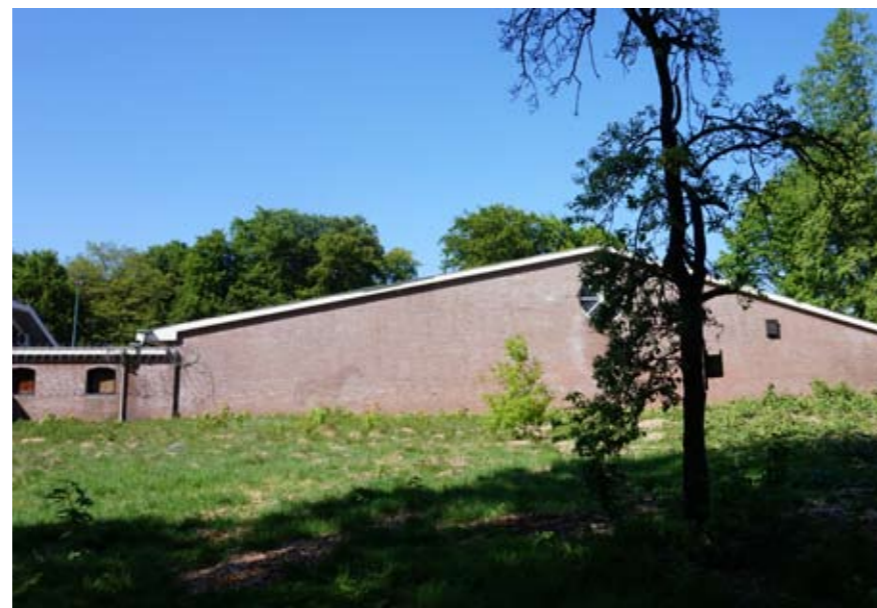
Huidige zuidgevel stal
