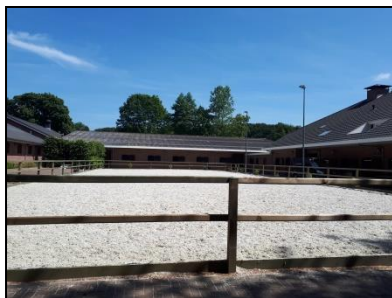
Figuur 3. Dressuurhal achter paarden buitenrijbak die gesloopt gaat worden.
