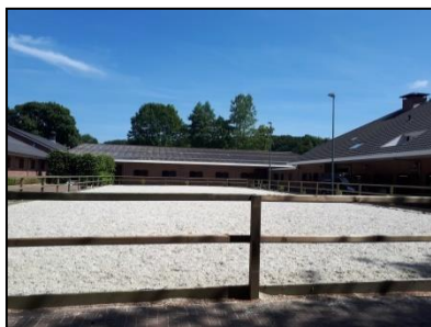
Figuur 2. Dressuurhal achter paarden buitenrijbak die gesloopt gaat worden.
