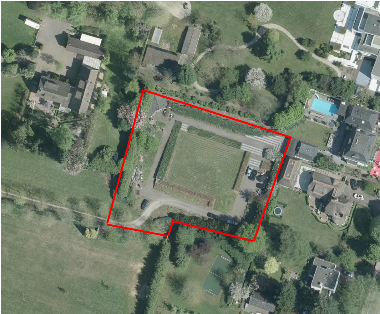
De planlocatie achter de woningen aan de Dreyenseweg. De locatie wordt vanuit het westen ontsloten vanaf de Johannahoeve.
