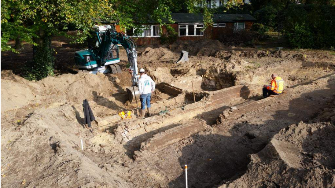
Figuur 3: Funderingsrestanten in bouwblok B (bron: archief REASeuro)
