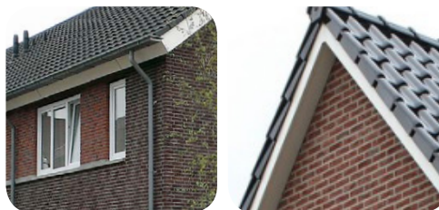
dakoverstek / verbijzondering in de gevel
