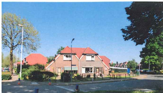
symmetrische gevel en dakvorm
