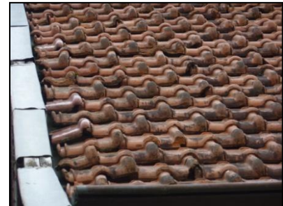
Figuur 9. Potentiële nestgelegenheid voor huismussen onder de dakpannen
