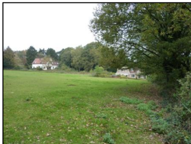
Figuur 3. Zicht op het bedrijfsgebouw vanuit begraasde weide (oostelijk terrein)
