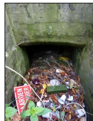
Figuur 13. Kelderruimte ter plaatse van voormalige kas.
