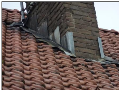
Figuur 10. Ruimte onder dakpannen en daklood vormen geschikte verblijfplaatsen voor vleermuizen
