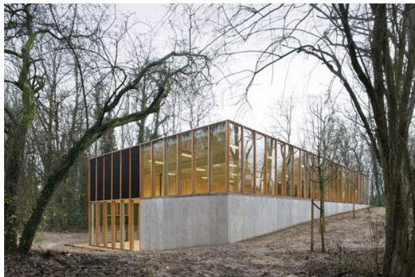
Het gebouw heeft een alzijdig karakter
