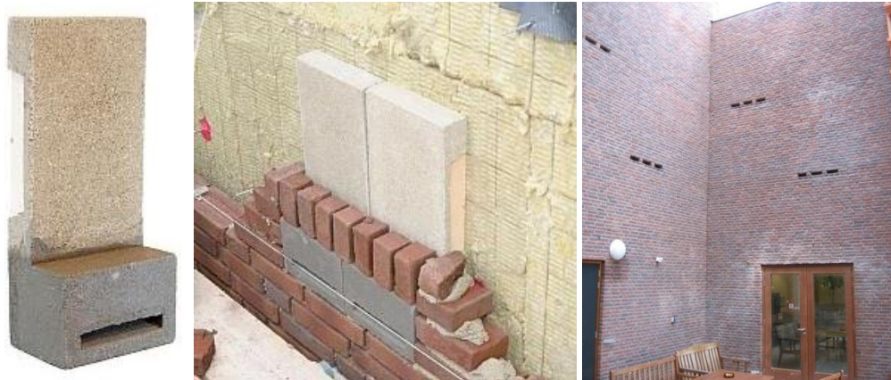
Een inbouwkast kan op een nette manier worden weggewerkt in een spouwmuur.
