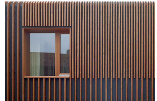
Geleding en ritmiek om schaal te brengen in het gebouw
