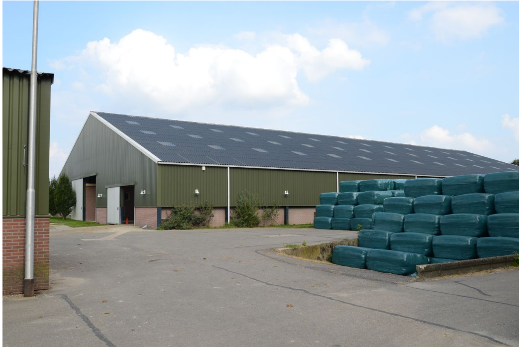
Figuur 8: bedrijfsgebouwen en opslag
