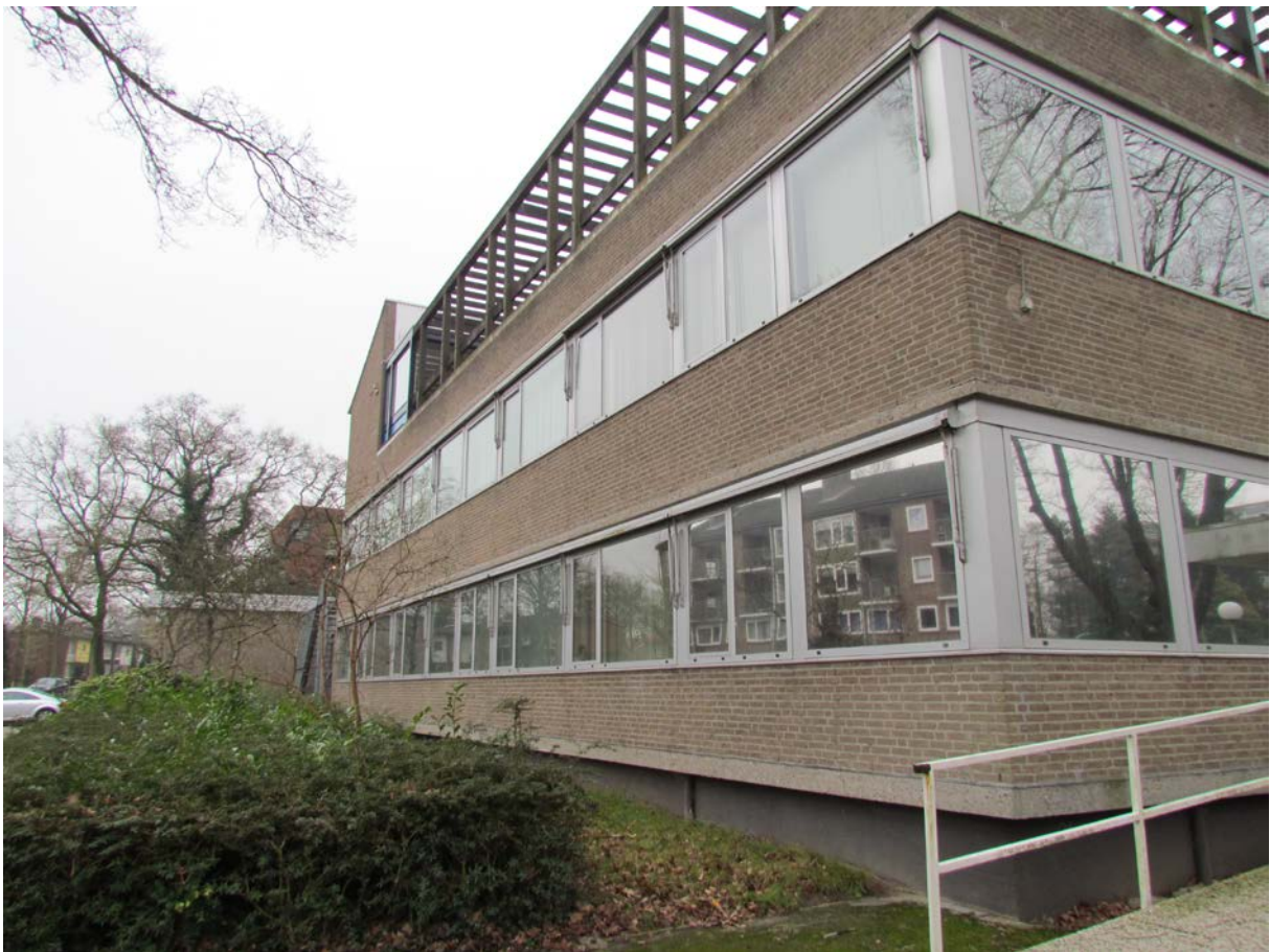
Oostgevel van het voormalige politiebureau aan de Van der Molenallee 8 in Doorwerth
