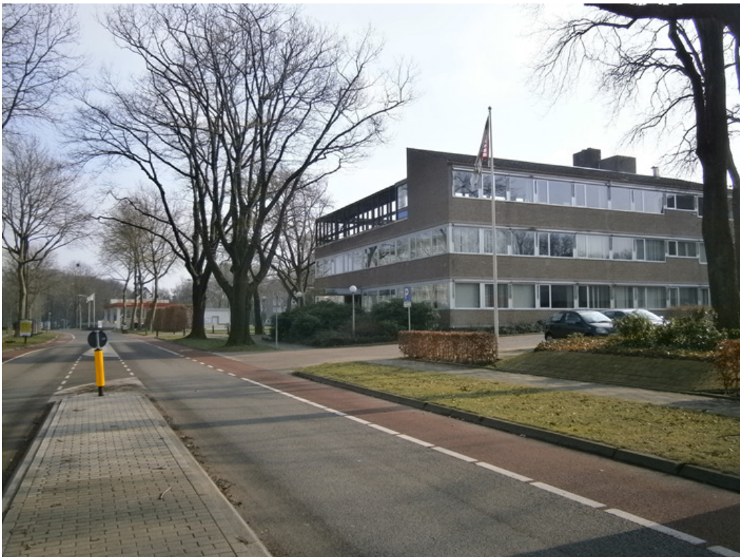
Foto huidige situatie voormalig politiekantoor te Doorwerth (kijkrichting: zuidoost)
