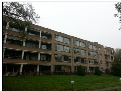
Figuur 4. Achterzijde bebouwing.
