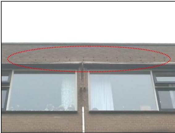
Figuur 12. Open stootvoegen.
