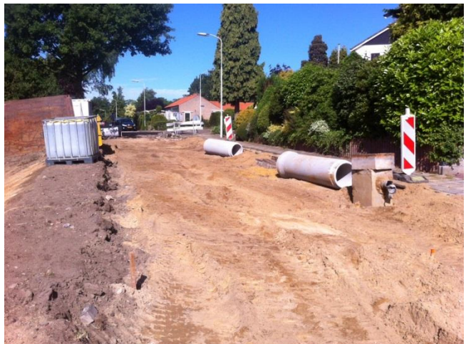
Reconstructie en riolvervanging Zuiderbeekweg
