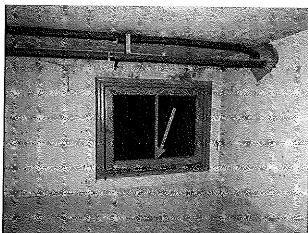
foto: stopverf raamkozijn berging (MM14)
