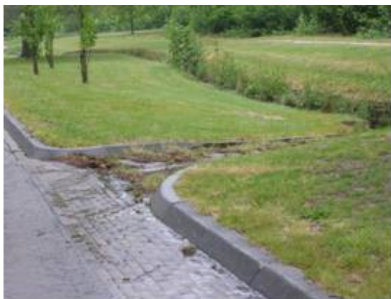
Foto 4.3 Afgekoppeld regenwater wordt afgevoerd naar groenvoorziening (Nico Bovenweg, Oosterbeek) (bron: Duker, 2007)
