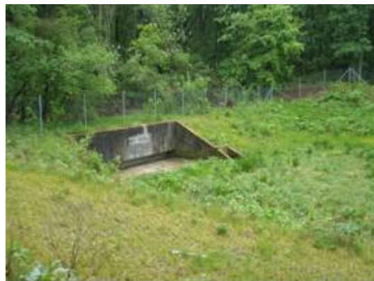
Foto 3.2 Berging Doorwerth (bron: Duker, 2007)
