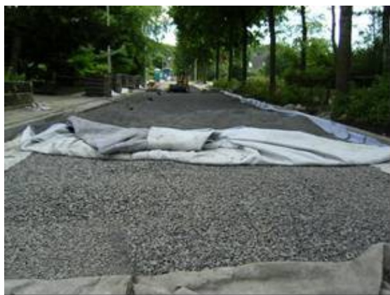
Foto 4.1 Aanleg aquaflow Bram Streeflandweg (Bron: (Bron: Bruil BV)
