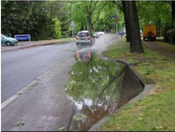
Foto 5.1 Verstepte afvoerbuiscap naar wadi op de Molenallee (bron: Duker, 2007)
