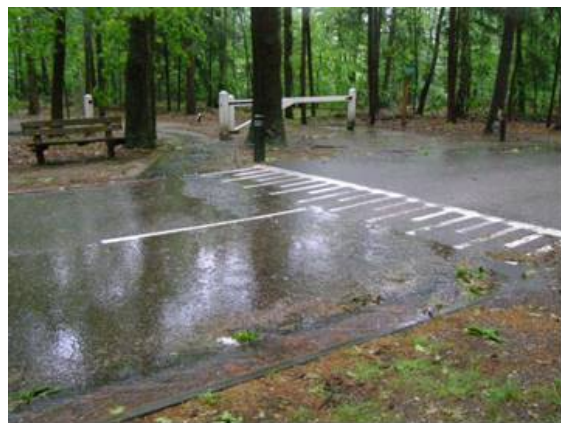
Foto 4.4 Afgekoppeld regenwater wordt d.m.v. drempel naar bos afgevoerd (Valkenburglaan, Oosterbeek) (bron: Duker, 2007)
