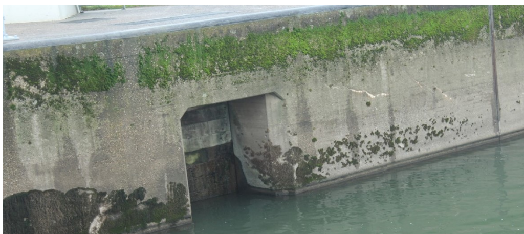
Figuur 4 Afsluiting van noord- en zuid-pijler met schotbalken
