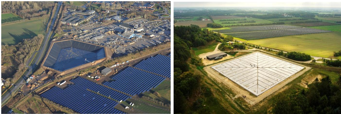
Afbeelding 10.6 Voorbeelden grootschalige thermische putten. Links Vojens, Denemarken (in aanbouw, 200.000 m 3 ) (1) , rechts Dronninglund, Denemarken (60.000 m 3 )
